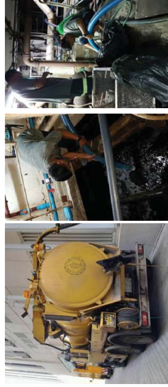
การสูบลบตะกอนจากระบบบำบัดน้ำเสีย
